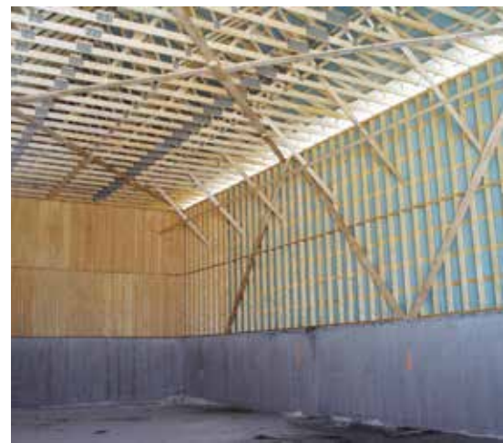
Voici un bel exemple d'une structure ventilée correctement. Tout est en bon état tant les plaquettes que le bois.
