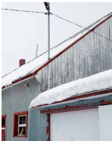
Cette photo est un bel exemple d'un toit qui pourrait facilement se retrouver en surcharge en raison d'une pente plus faible et d'un toit plus bas.
