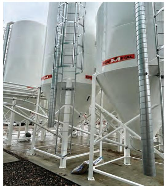
Les quantités de moulée sont très petites. Or, aucune meunerie ne peut fabriquer d'aussi petites quantités. Il fallait donc deux mini-meuneries (photo à gauche) sur place dont l'une a des microdoseurs précis au gramme près. Pour l'une, il y a quatre silos extérieurs et huit intérieurs, alors que l'autre mini-meunerie a 20 silos extérieurs (photo à droite).
