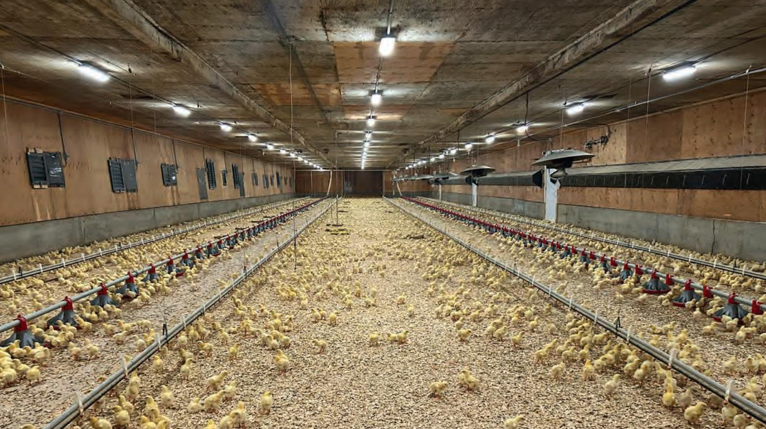
Le poulailler d'un étage fait 40 pieds sur 180 pieds (12,2 sur 55 mètres). Les entrées d'air sont à droite et les ventilateurs d'extraction d'air à gauche. Il y a quatre lignes d'eau et deux lignes de moulée. Une porte à l'extrémité permet d'entrer avec la machinerie à l'intérieur du bâtiment pour le nettoyage entre les lots. Lors de la rénovation, la toiture a été renforcée pour permettre de retirer les poutres intérieures, ce qui facilite le nettoyage.
